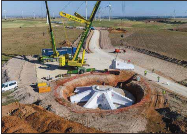
Afbeelding 2.7 - Artepref windturbine fundatie ( www.artepref.com , sd)
