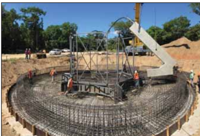
Afbeelding 2.9 - Braced Foundations windturbine fundatie ( www.esteyco.com , sd)
