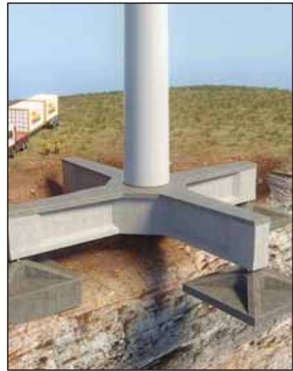
Afbeelding 2.11 - HWS AirBASE windturbine fundering ( www.hwstowers.com , sd)
