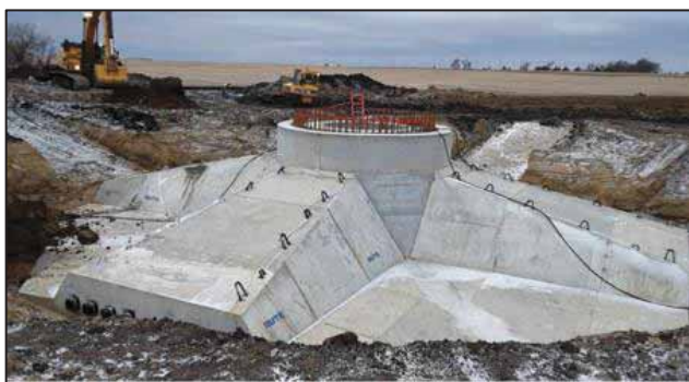
Afbeelding 2.5 - RUTE Foundations - Aanbrengen grond op geprefabriceerde fundering (www.rutefoundations.com, sd)
